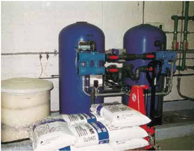
Ion Exchanger / Ionentauscher
